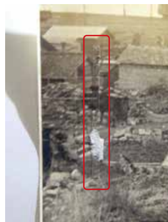
テープの箇所
