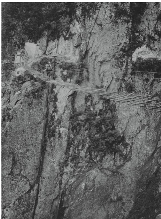
冠松次郎 《奥仙人谷の吊り橋》 1925 (大正 14) 年 8 月
